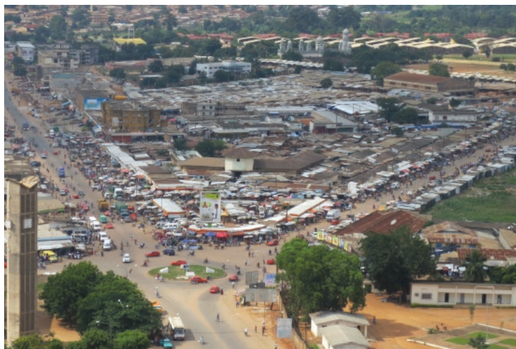
Zone de réaménagement du Marché central
