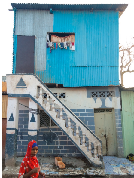
maison à R+1 à dans le quartier de Djaga Bouldouq
