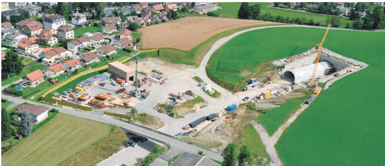
Portail ouest du Tunnel Sous le Mont du tronçon N16 Tavannes-Loveresse ( www.a16.ch )
