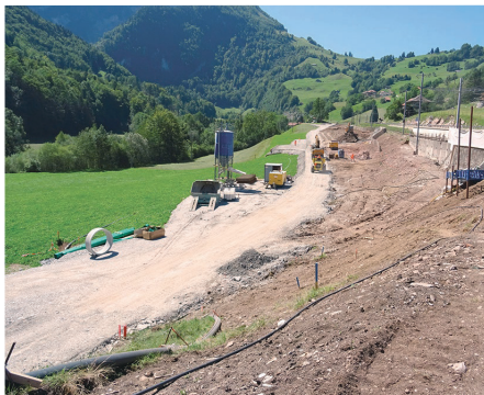
Terrassement du chantier de la gare de Montbovon
