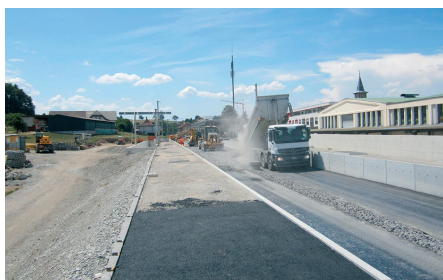
Renouvellement de la gare de Belfaux-Village
