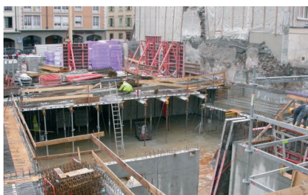
Les travaux de gros-oeuvre du chantier de Rolle
