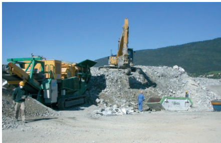
Production de gravas de recyclage, Marin-Centre
