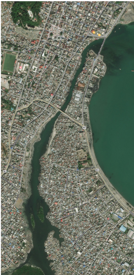
Exutoire du bassin Rhodo
