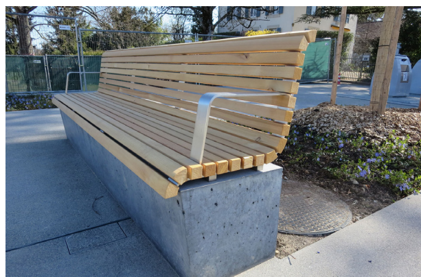
Réalisation du banc bois sur socle en béton teinté
