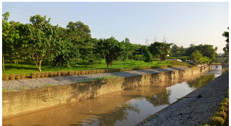
Infrastructure de drainage urbain intégrant des SBN
